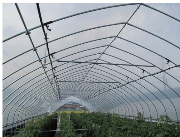
第 2 図 ミスト設置状況
