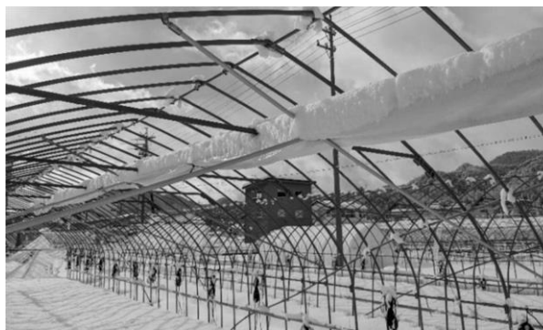
図10 内張クロス遮光越冬時積雪状況(2022. 2. 18)
