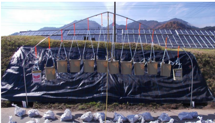
大型バケツと土嚢袋を使った載荷試験の様子
