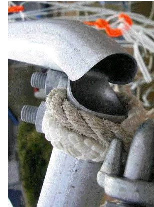
図8 外ジョイントの破壊
