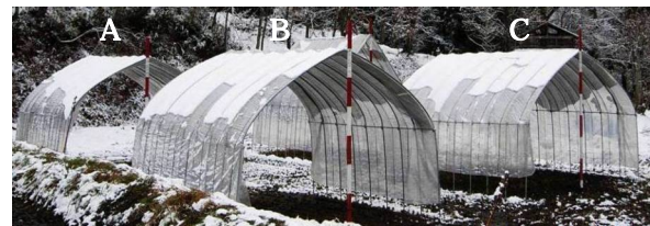
図7 現地実証ハウス(撮影日2008年12月6日)
