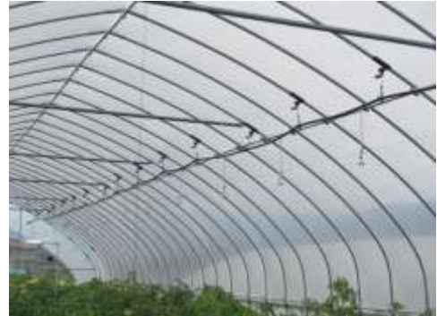
低圧ミスト散水装置の設置の様子
